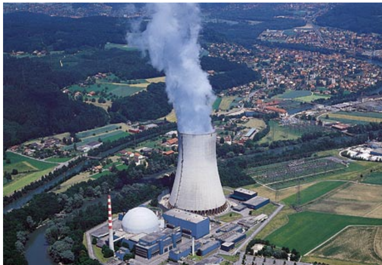
Centrale nucléaire de Gösgen
